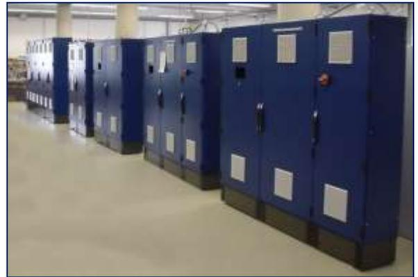
Niederspannungs-Schaltanlagen als TSK / PTSK nach DIN EN 60439-1
